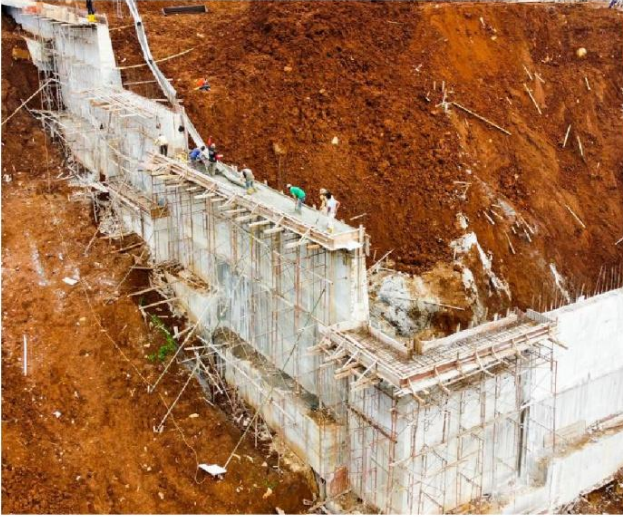
Dago Pakar, Bandung Retaining Wall
